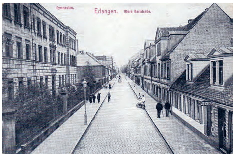
Abb. 5 Obere Karlstraße Erlangen mit Gymnasium (um 1890).
